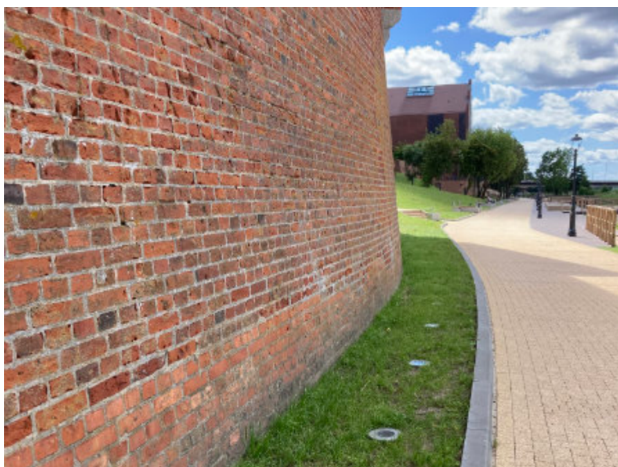
Ryc. 23. Iluminacja murów zamkowych i oświetlenie bulwaru (bulwar w Malborku)
