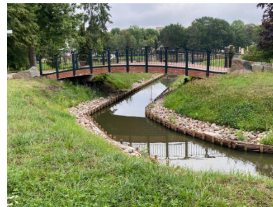
Ryc. 59. Zabezpieczenie brzegu z materiałów naturalnych i odnawialnych (park 1000-lecia w Chojnicach)
