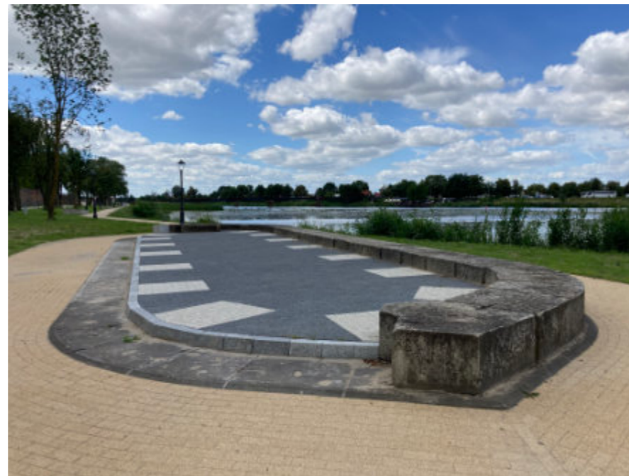
Ryc. 48. Mało udana próba rekonstrukcji zarysu historycznych pozostałości pylonu mostu kolejowego (bulwar w Malborku)
