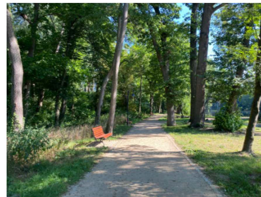
Ryc. 109. Ciąg pieszy z nawierzchnią półprzepuszczalną
