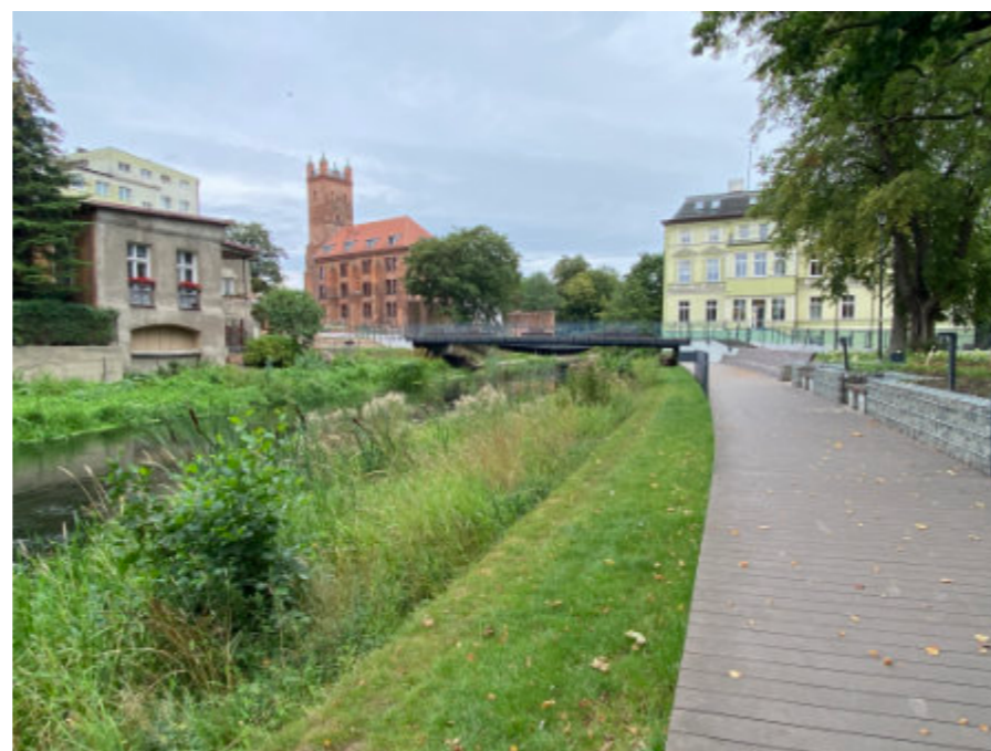
Ryc. 100. Chodnik wykonany z desek kompozytowych na brzegu Słupi
