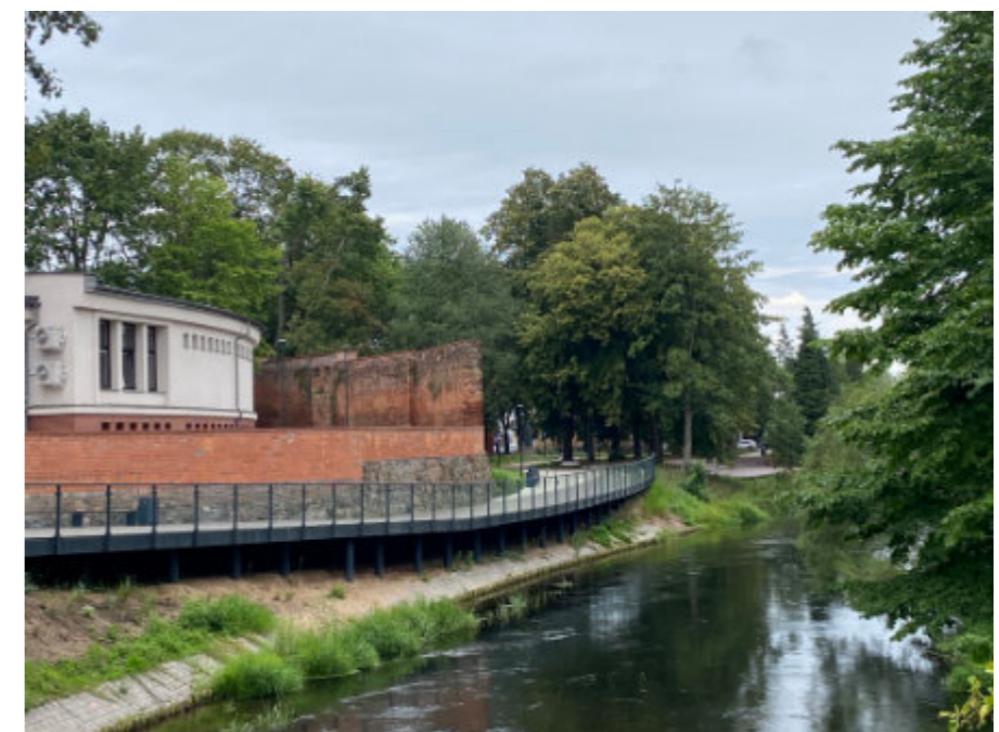
Ryc. 25. Konstrukcja nadwodnej kładki (bulwary w Słupsku)
