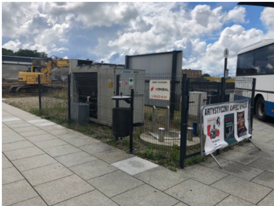
Ryc. 47. Wyeksponowana infrastruktura techniczna (węzeł w Kartuzach)
