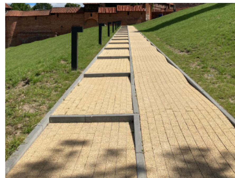
Ryc. 33. Niewłaściwe rozwiązanie - schody terenowe i pochylnia bez poręczy (bulwar w Malborku)
