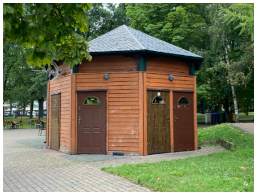
Ryc. 40. Budynek z toaletami (Park 1000-lecia w Chojnicach)
