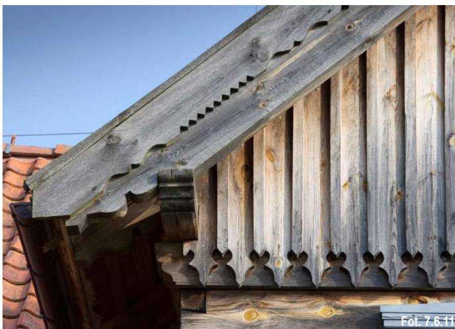
Fot. 7.6.9 Laubzegowa konsola jako ozdobnik płatwi domu w Żuławkach [MK]
