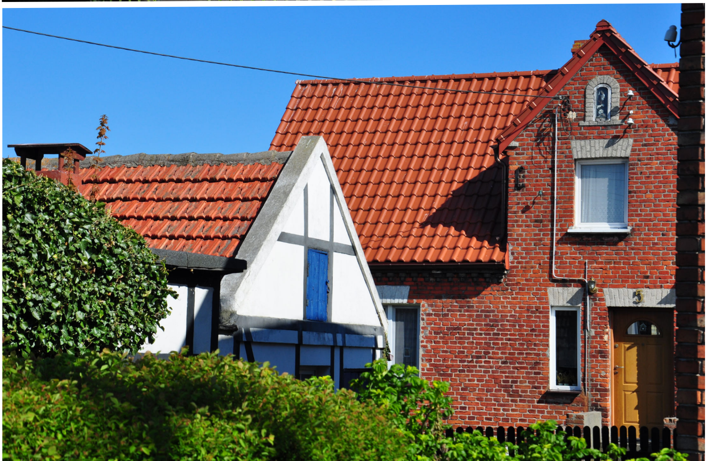
Fot. 22.; Fot. 23. Kuźnica, Żeglarska 5, elewacja ceglana z oryginalnym detalem (nadproża i fryz cementowy oraz kapliczka w szczycie wystawki), wymieniona solarka okienna bez podziałów, w bezpośrednim sąsiedztwie domu zachowany również w historycznej formie obiekt gospodarczy z charakterystyczną niegdyś przydomową wędzarnią
