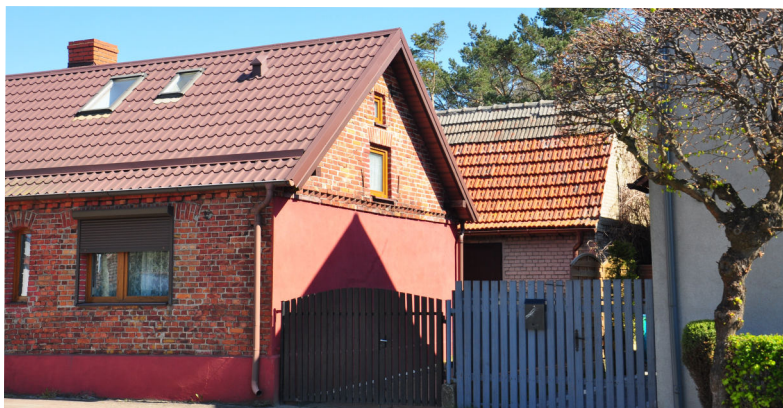
Fot. 9.; Fot. 10. Kuźnica, Helska 55, elewacja szczytowa częściowo otynkowana, zamurowany otwór drzwiowy, przemurowany jeden z otworów okiennych, wymieniona stolarka bez zachowania pierwotnych podziałów, dach kryty blachodachówką, w głębi widoczny budynek gospodarczy kryty dachówką ceramiczną, tzw. sercówką
