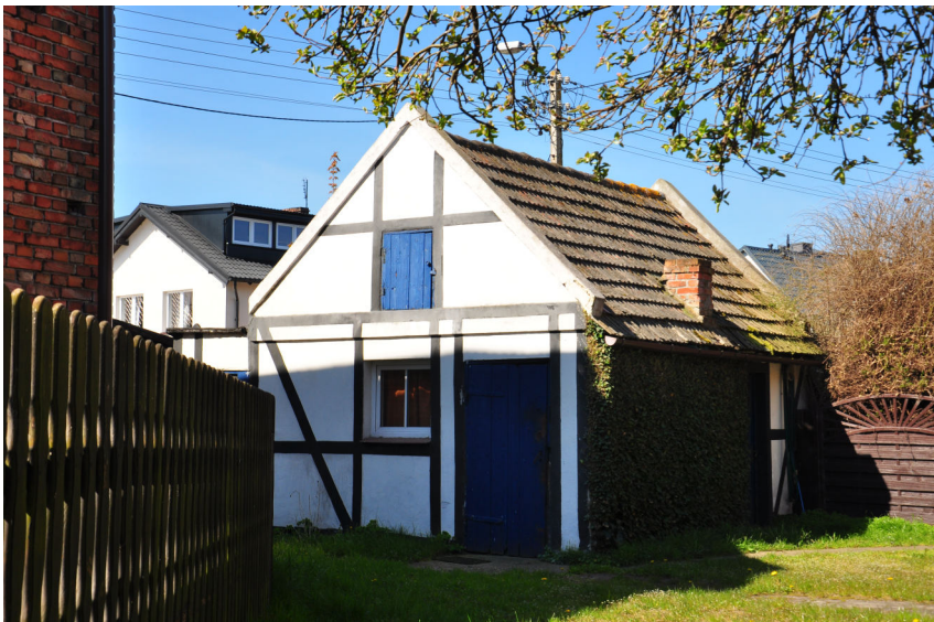
Fot. 35. Kuźnica, Żeglarska 5 - budynek gospodarczy z widocznym kominem wędzarni, dach kryty ceramiczną dachówką tzw. sercówką Fot. 36. Kuźnica, Pac Rybaków 16, pozostałości dawnej przydomowej wędzarni Fot. 37. Kuźnica, Żeglarska 5 - budynek gospodarczy, widok od strony podwórza
