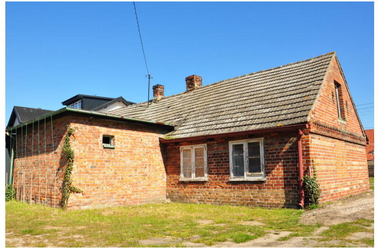
Fot. 11.; Fot. 12. Kuźnica, Szynalewskiego 1, widoczne zamurwane okno w ścianie szczytowej
