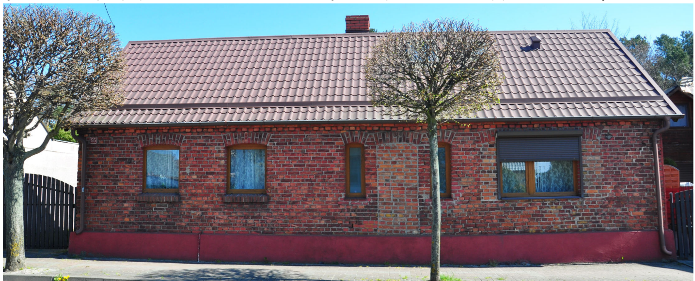
Fot. 8. Kuźnica, Helska 40, elewacja po remoncie otynkowana, pozostawiono jedynie fragmenty ceglane: gzyms podokapowy, łęki nadokienne, parapety oraz cokolik, stolarka okienna częściowo wymieniona, dach kryty blachodachówką
