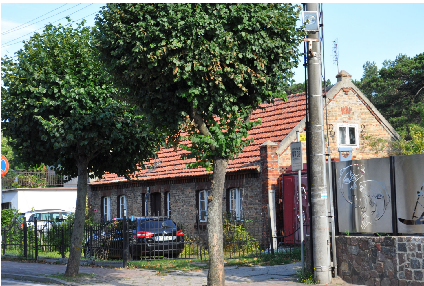
Fot. 2.; Fot. 3. Kuźnica, Helska 15, l. 30. XX w., zachowane m.in. oryginalna stolarka i pokrycie dachu (zakładkowa ceramiczna dachówka tzw. sercówka), fotografie wykonane przed realizacją przybudówki przestaniającej większość obiektu (patrz: Fot. 16)
