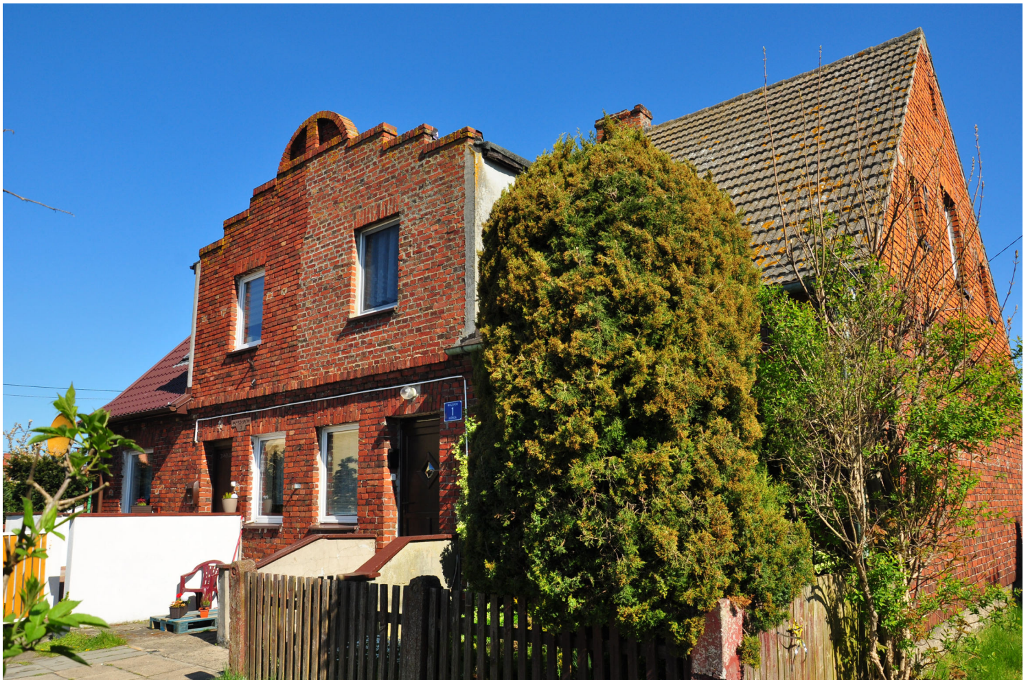
Fot. 27. Kuźnica, Maszopów 1 - 3; Kuźnica, Maszopów 1 - przykład domu bliźniaczego z ryzalitem (z końca XIX w.), utrzymana forma bryły budynku, wymieniona stolarka bez pierwotnych podziałów, przemurowana połowa szczytu ceglanego wystawki
