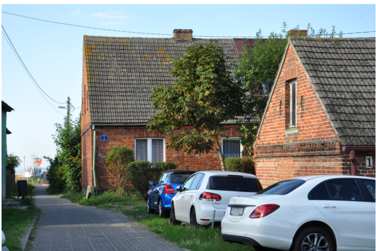
Fot. 28.; Fot. 29. Kuźnica, Maszopów 1 - 3 - widok od strony podwórza, na pierwszym planie budynek w typie I (Szydalewskiego 1), na połowie domu wymienione pokrycie dachowe na blachodachówkę
