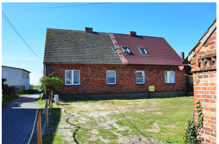
Fot. 28.; Fot. 29. Kuźnica, Maszopów 1 - 3 - widok od strony podwórza, na pierwszym planie budynek w typie I (Szydalewskiego 1), na połowie domu wymienione pokrycie dachowe na blachodachówkę
