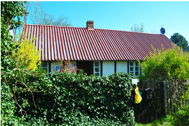
Fot. 13. Kuźnica, Hallera 28, wymienione pokrycie dachowe na blachodachówkę,
