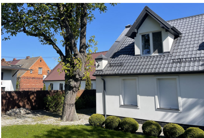
Fot. 7. Kuźnica, Żeglarska 13 - przykład chałupy rybackiej istotnie przekształconej w wyniku remontu (przemurowania otworów okiennych, dodane lukarny, wymiana stolarki oraz pokrycia dachowego, itd. nadal do odczytania jednak zasadnicza bryła i proporcje historycznego budynku z zachowanym charakterystycznym zdobieniem narożnika
