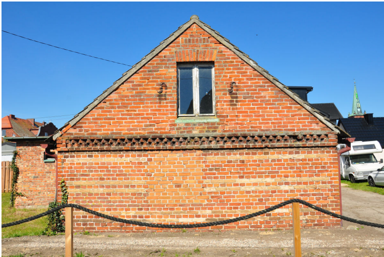
Fot. 11.; Fot. 12. Kuźnica, Szynalewskiego 1, widoczne zamurwane okno w ścianie szczytowej
