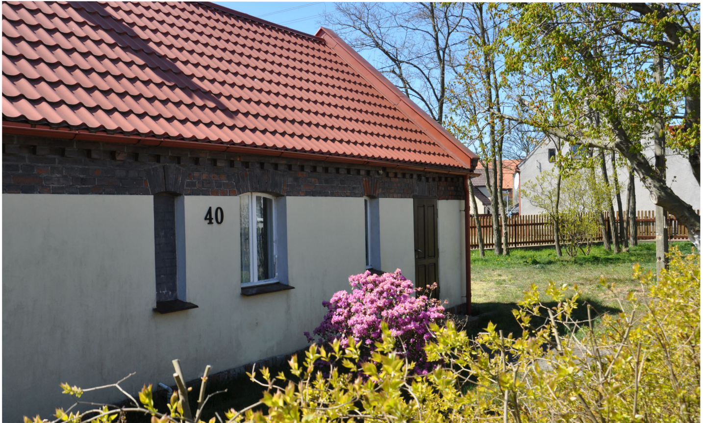
Fot. 8. Kuźnica, Helska 40, elewacja po remoncie otynkowana, pozostawiono jedynie fragmenty ceglane: gzyms podokapowy, łęki nadokienne, parapety oraz cokolik, stolarka okienna częściowo wymieniona, dach kryty blachodachówką
