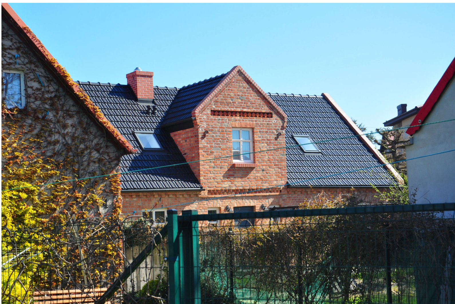
Fot. 26. Kuźnica, Bursztynowa 2, dom po gruntownym remoncie z zachowaniem form i materiałów nawiązujących do historycznych (wyjątek stanowi dachówka)
