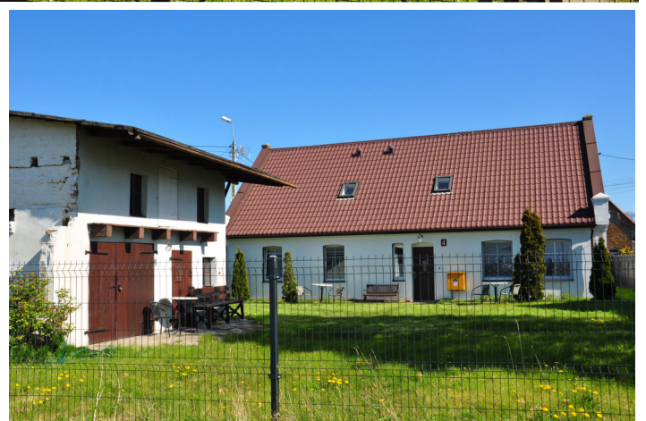
Fot. 4.; Fot. 5.;Fot. 6. Kuźnica, Maszopów 4, elewacja po remoncie otynkowana, stolarka okienna wymieniona na okna z zamarkowanym podziałem, dach kryty blachodachówką
