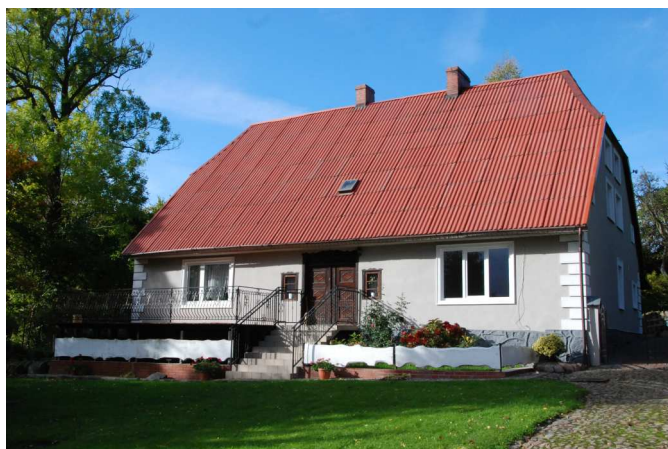
Fot. 73. Możdżanowo, dom mieszkalny nr 5
