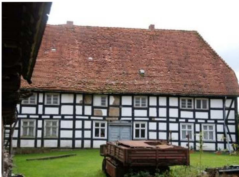
Fot. 59. Swółowo, dom mieszkalny w zagrodzie nr 8
