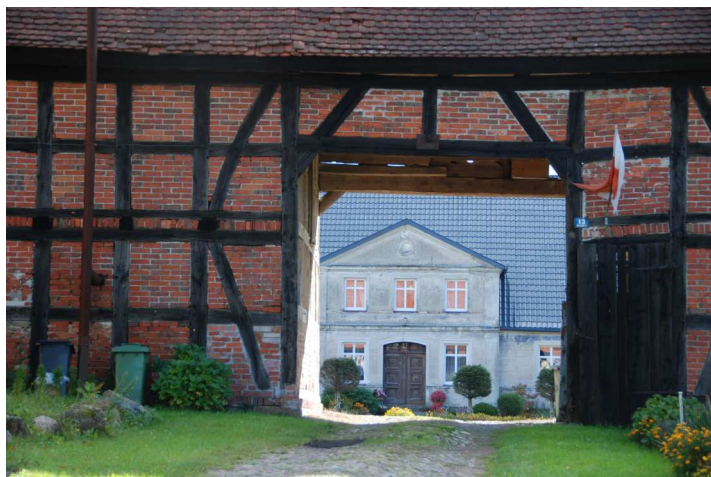
Fot. 21. Bruskowo Małe, budynek bramny w zagrodzie nr 13
