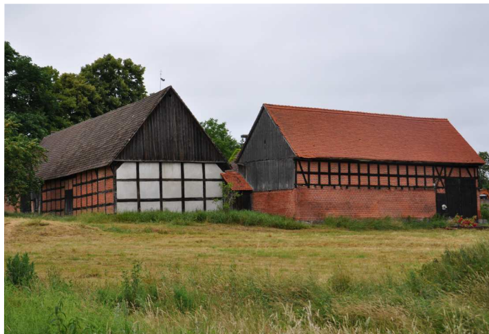
Fot. 19. Starkowo, budynek bramny w zagrodzie nr 53
