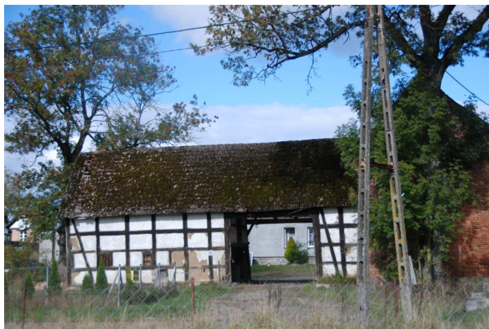
Fot. 13. Swołowo, budynek bramny w zagrodzie nr 4
