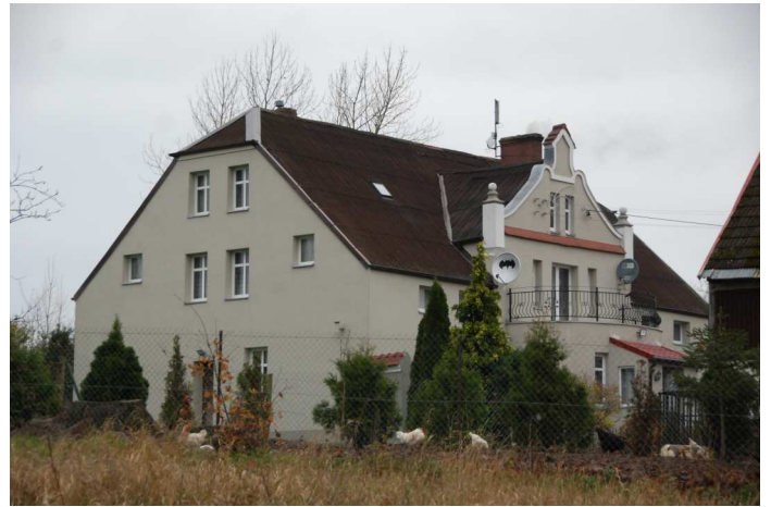
Fot. 62. Możdżanowo, dom mieszkalny nr 4
