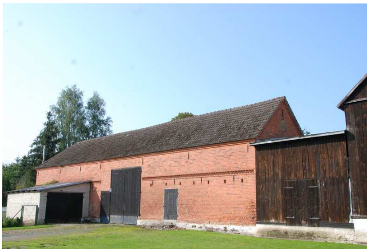
Fot. 18. Możdżanowo, budynek bramny w zagrodzie nr 8
