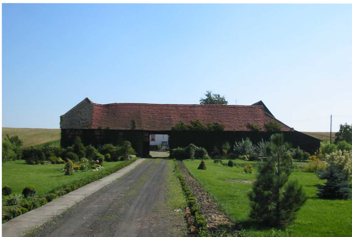
Fot. 17. Starkowo, budynek bramny w zagrodzie nr 13
