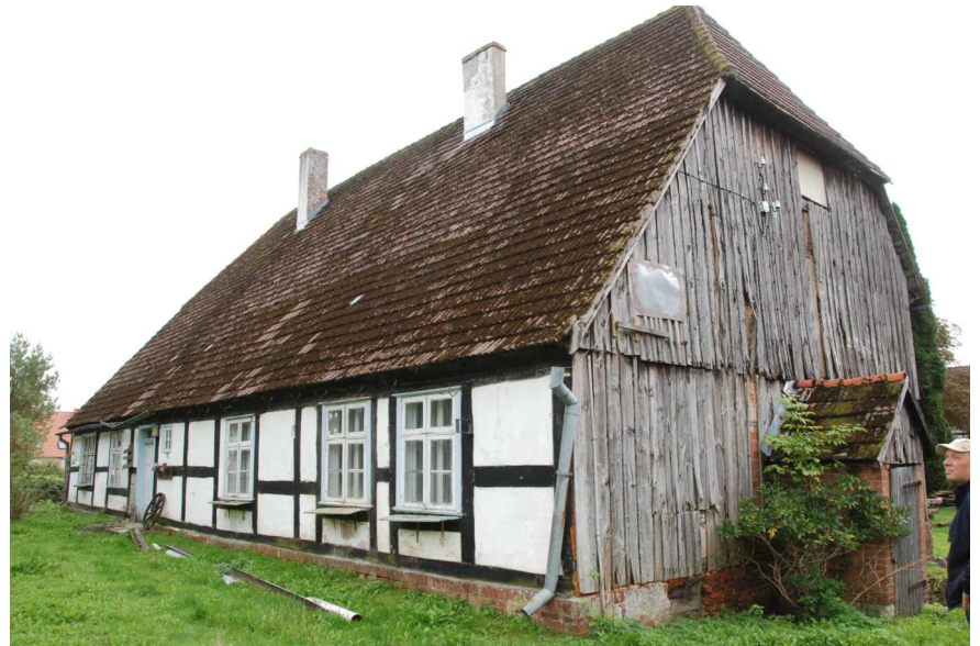
Fot. 56. Swołowo, dom mieszkalny w zagrodzie nr 13, widok od tyłu
