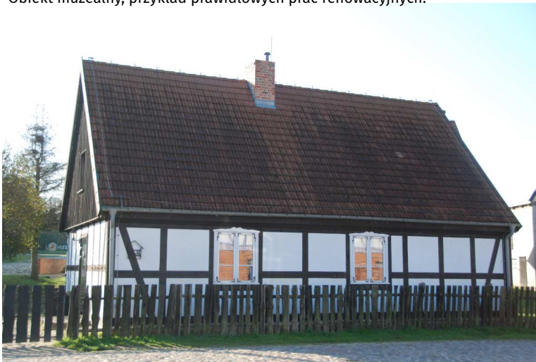
Fot. 33. Swółowo, dom mieszkalny w zagrodzie nr 15
