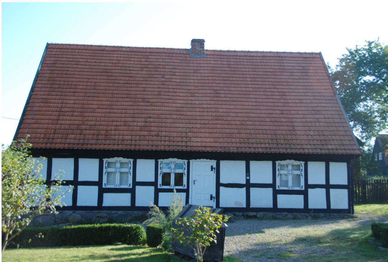
Fot. 10. Swołowo, dom mieszkalny w zagrodzie nr 14
