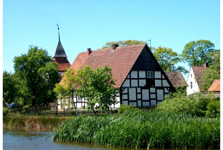
Fot. 40. Swołowo, dom mieszkalny w zagrodzie nr 38
