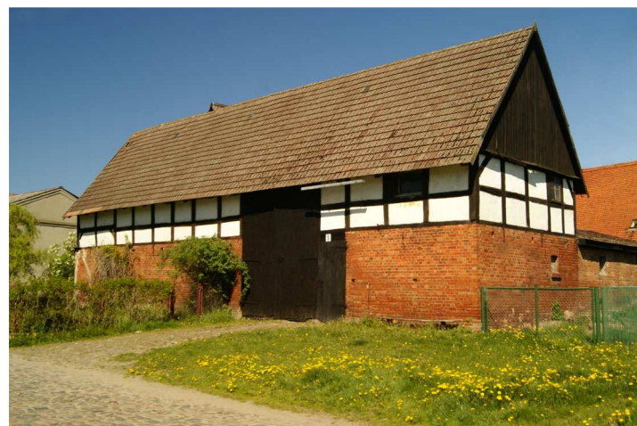
Fot. 16. Swołowo, budynek bramny w zagrodzie nr 5
