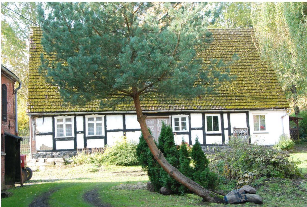
Fot. 11. Możdżanowo, dom mieszkalny nr 15
