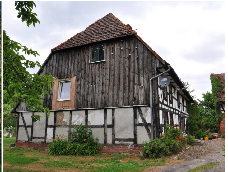
Fot. 54. Bruskowo Małe, szczyt domu mieszkalnego nr 6
