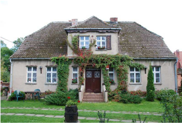
Fot. 61. Możdżanowo, dom mieszkalny nr 17
