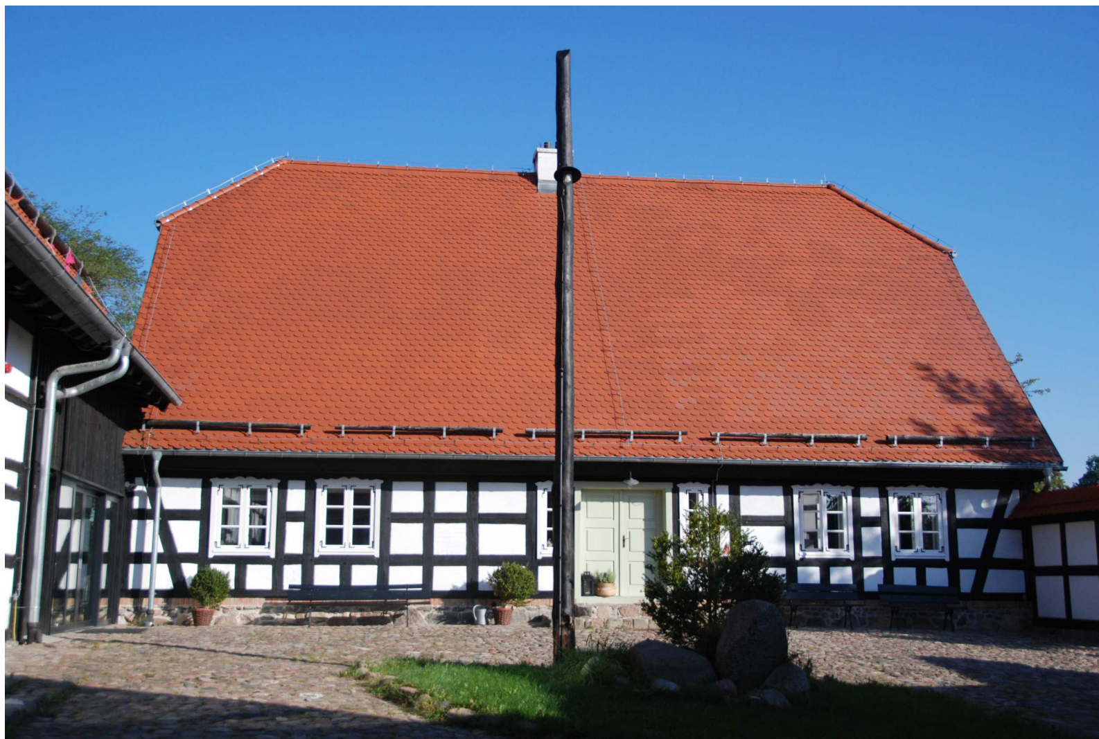
Fot. 49. Swółowo, dom mieszkalny w zagrodzie nr 5
