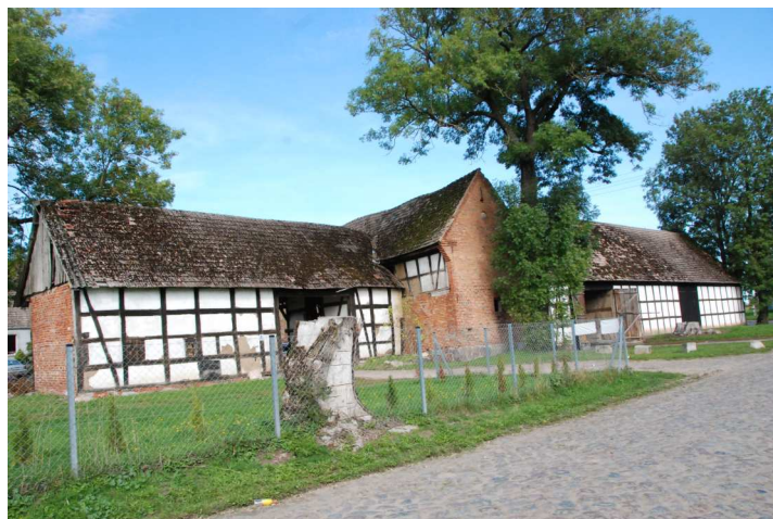
Fot. 14. Swołowo, budynki bramne w zagrodach nr 3 i 4
