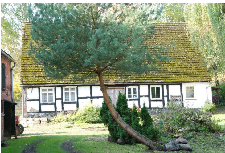
Fot. 41. Możdzanowo, dom mieszkalny nr 15
