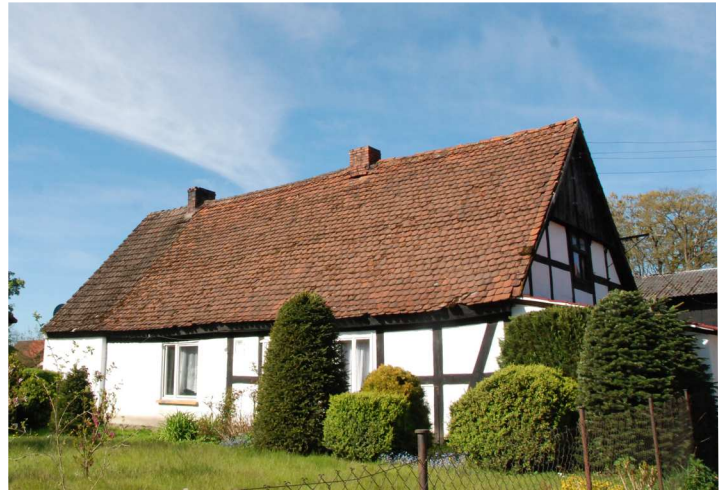
Fot. 38. Swołowo, dom mieszkalny w zagrodzie nr 37
