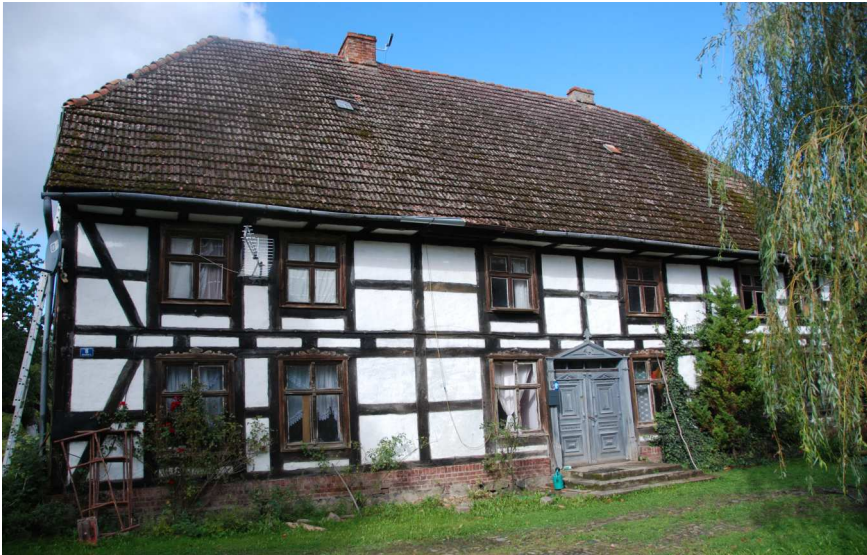
Fot. 53. Bruskowo Małe, dom mieszkalny nr 6
