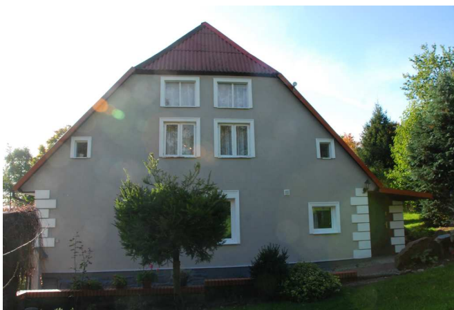
Fot. 74. Możdżanowo, szczyt domu mieszkalnego nr 5
