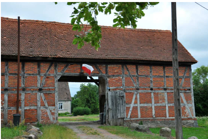
Fot. 20. Bruskowo Małe, budynek bramny w zagrodzie nr 13
