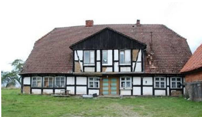
Fot. 51. Swołowo, dom mieszkalny w zagrodzie nr 9
