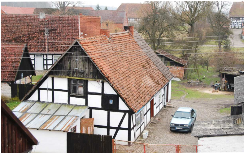
Fot. 37. Swołowo, dom mieszkalny w zagrodzie nr 37
