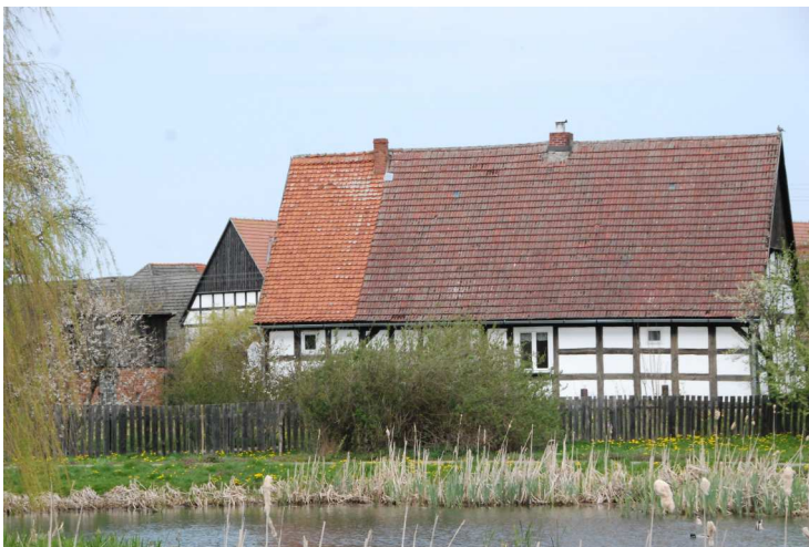
Fot. 39. Swołowo, dom mieszkalny w zagrodzie nr 38
