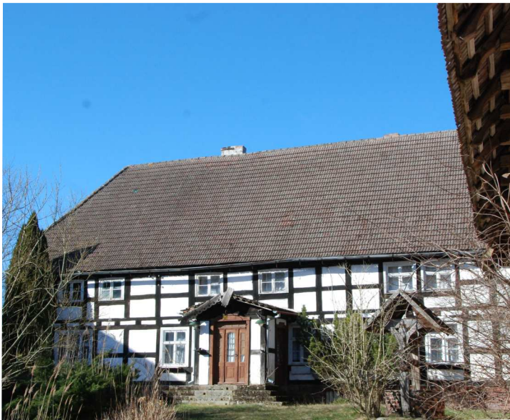
Fot. 55. Swołowo, dom mieszkalny w zagrodzie nr 13
