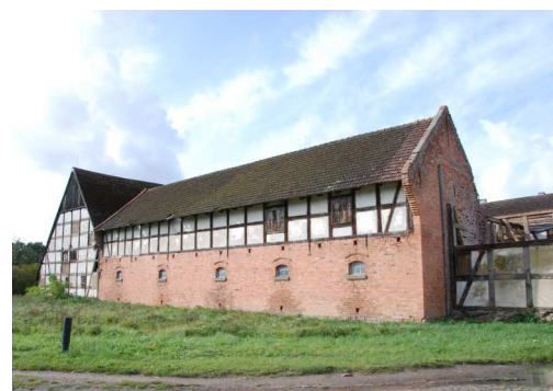
Fot. 24. Starkowo, budynek inwentarski w zagrodzie nr 13
