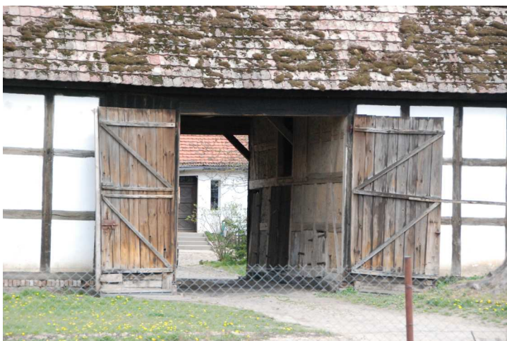
Fot. 12. Swołowo, budynek bramny w zagrodzie nr 3
